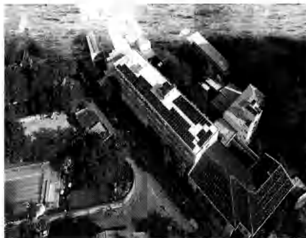
Escolas IESA 204 kWp
