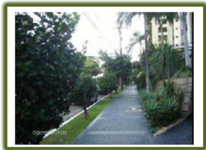
**Atenção: Aderir o Espaço árvore** é interessante nas calçadas dos novos **loteamentos**, a calçada deve ser construída com o mínimo de largura de 2,5m, considerando 40% da largura, teremos  $2,5 \times 40\% = 1\text{m}$  de largura e o comprimento do espaço deverá ter, no mínimo, 2 m de comprimento, com finalidade de melhor desenvolvimento da árvore, pois as raízes terão maior sustentação e infiltração das águas das chuvas ou irrigação.
